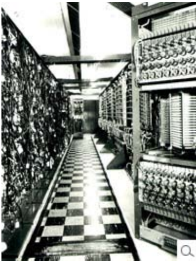
Whirlwind installation at MIT
